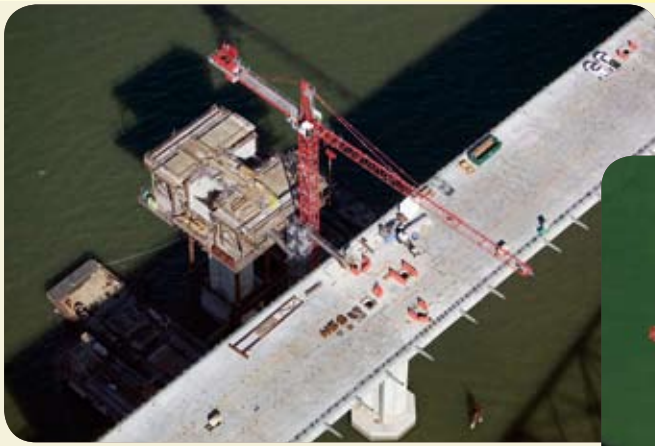
旧金山奥克兰湾跨海大桥桥面新建工程。 Construction of the replacement span for the San Francisco Oakland Bay Bridge.
