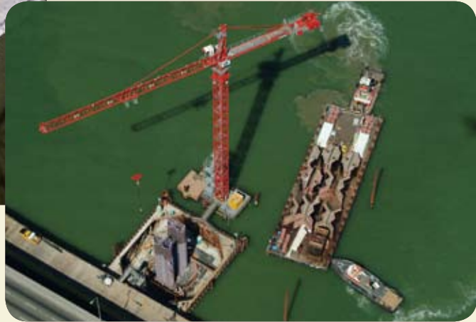
建设中的旧金山奥克兰湾跨海大桥桥墩工程。 Construction of the first footing for the San Francisco Oakland Bay Bridge replacement span.
